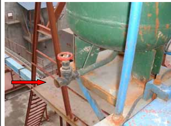
图 3. 贮气罐底部的排污阀要定期打开排污
