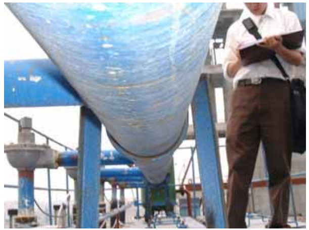
图 2. 气包底部没有安装排污阀。
